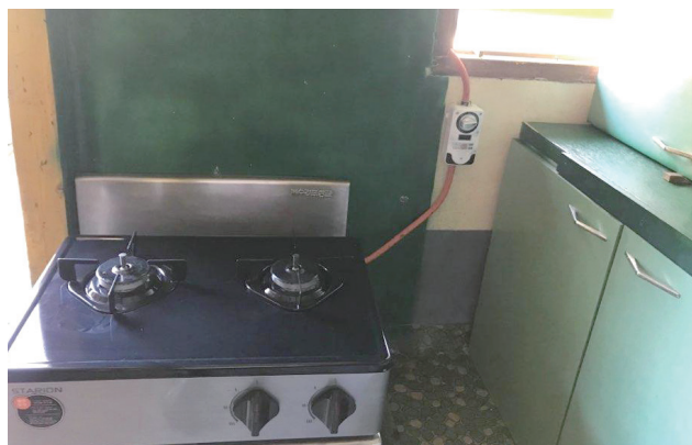
3-2. 가스자동잠금장치 설치(장성군 일대) [한국가스안전공사 광주전남지역본부]
