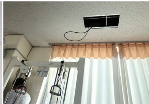
스캐너 전기 배선 작업
